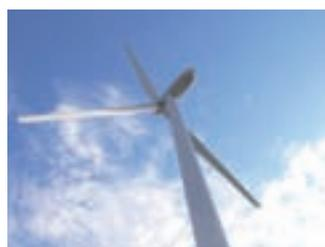
2MWダウンウィンド型風力発電システム
