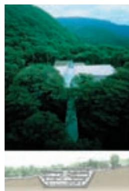
断面図：すり鉢状の下部構造で、地下水脈の流れを分断しないよう配慮
