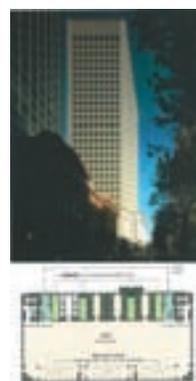
着脱可能な床を備え、各階には、トイレ・設備機器を2セットずつ設置
