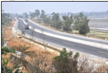
Một đoạn đường thuộc Dự án nâng cấp mở rộng QL1 đoạn Nam Bến Thủy - Hà Tĩnh được đầu tư bằng hình thức BOT - Ảnh: Dương Linh
